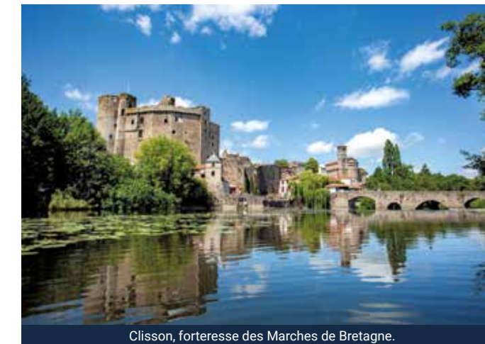
Clisson, forteresse des Marches de Bretagne.
